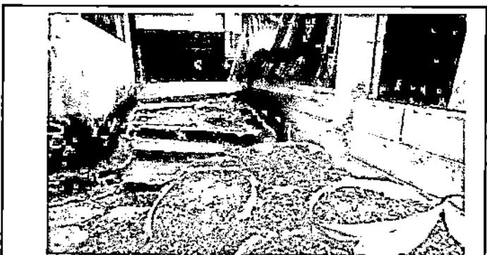
Foto 6: Área de cocina, se debe mejorar el acceso a la misma y un entortado de cemento dentro de la misma.
