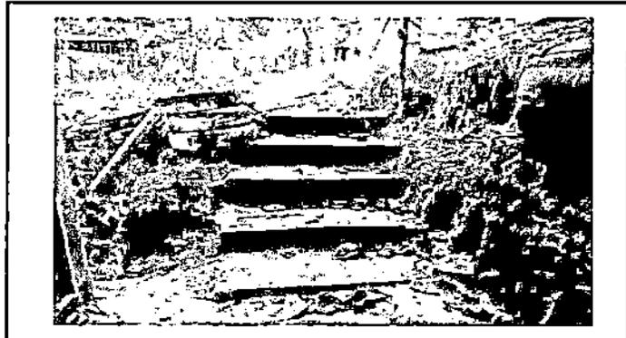
Foto 2: Área de banqueta de baja de gradas para los baños en malas condiciones, mejorarlas para poder facilitar el acceso de los estudiantes.
